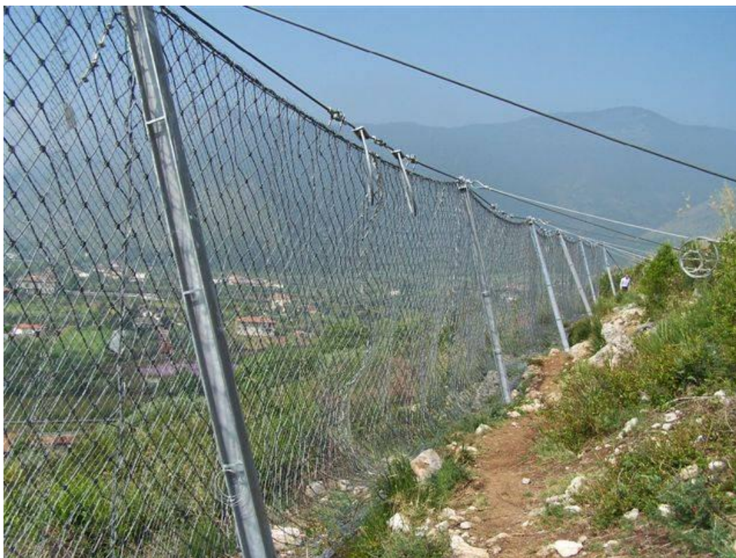
FOTO 7 - Intervento di protezione dell'abitato di Monte San Biagio dalla caduta massi mediante barriere paramassi ad elevata dissipazione di energia. Committente: Comune di Monte San Biagio (LT). Anno 2004
