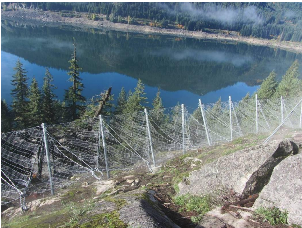
FOTO 6 - Intervento di protezione della Autostrada Interstate I90 dalle valanghe con reti da neve a Snoqualmie Pass, WA. Committente: Maccaferri USA per conto del WSDOT (Washington Department of Transportation). Anni 2013, 2014 e 2015.
