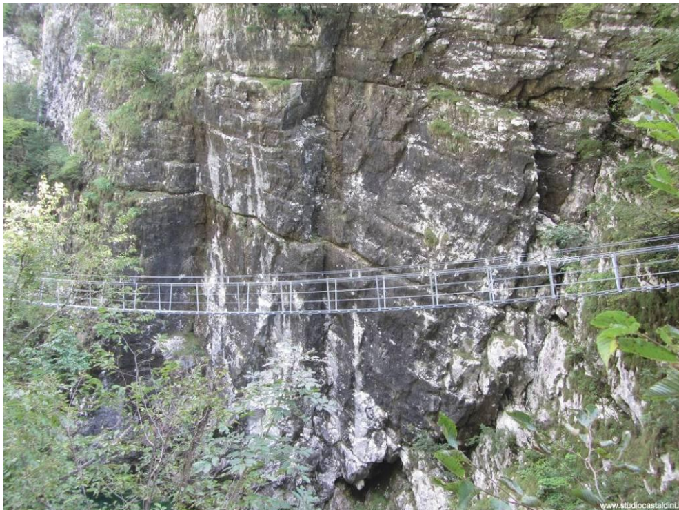
FOTO 2 - Ponte tibetano della Valcellina (PN), L = 48 m, da percorrere con imbragatura e kit da ferrata - Committente: Impresa BOZ srl per conto del Comune di Barcis (PN). Anno 2014
