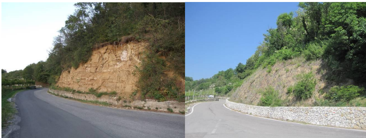
FOTO 8 - Consolidamento corticale scarpata rocciosa con riprofilatura versante e posa di rete metallica armata e rinforzata in località Purano. Prima (a sx) e dopo (a dx) - Committente: Comune di Marano di Valpolicella (VR). Anno 2008.
