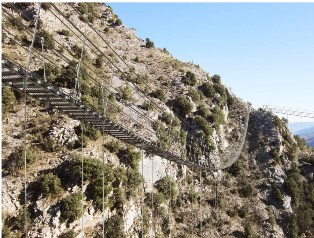
FOTO 4 - Ponte tibetano di Castelsaraceno (PZ), L = 780 m in 4 campate - Committente: Dolomiti Rocce SrL per conto del Comune di Castelsaraceno (PZ). Rendering dal Progetto Definitivo. Anno 2015.
